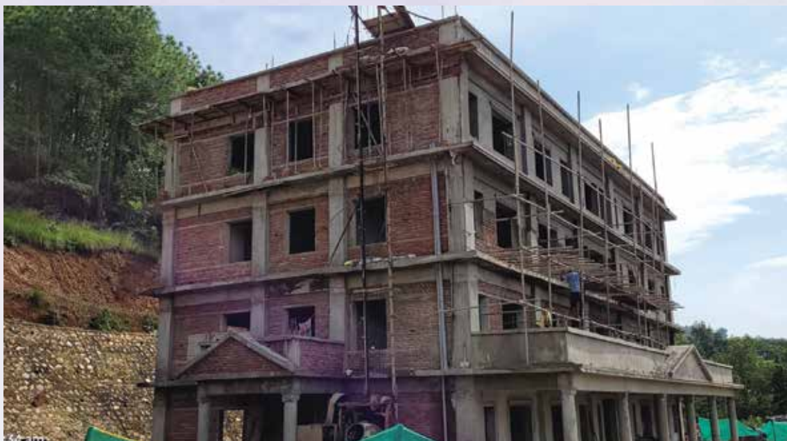
बगनासकाली गाउँपालिकाको निर्माणाधिन प्रशासनिक भवन
