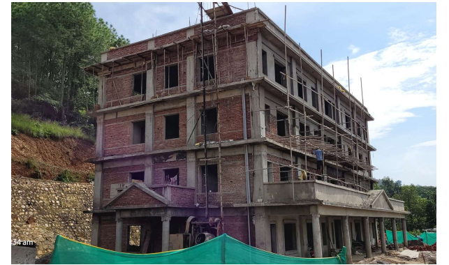
निर्माणधिन गाउँपालिकाको कार्यालय
